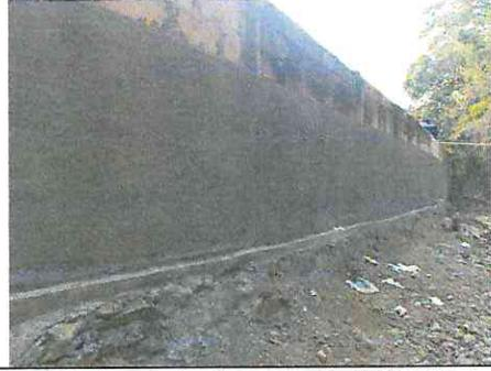
Foto 2: Recubrimiento y repello de muro perimetral finalizado
