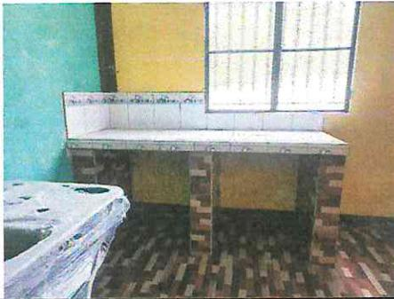
Foto 1: Construcción de mesa de cemento para cocina finalizado
